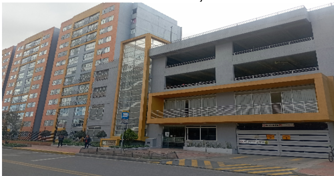
Fachada del Conjunto
