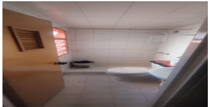
Baño Privado Hab 1
