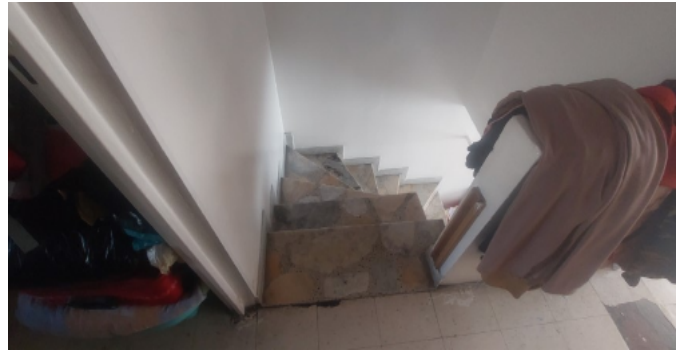
Escalera del inmueble
