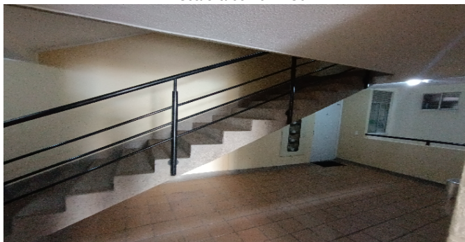
Escalera común - CJ
