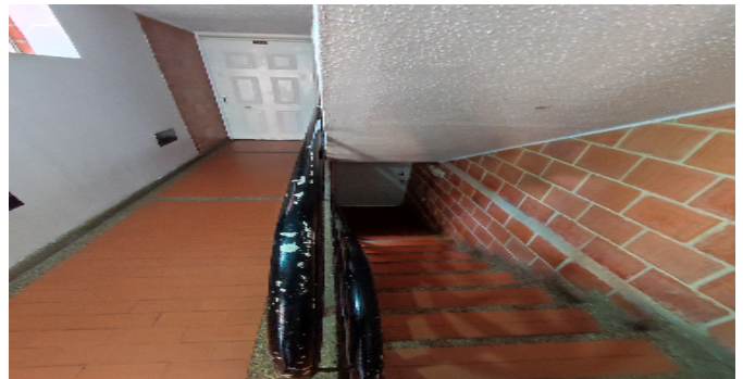
Escalera común - CJ
