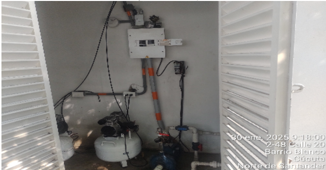
Motobomba Tanque Subterráneo Primer Piso
