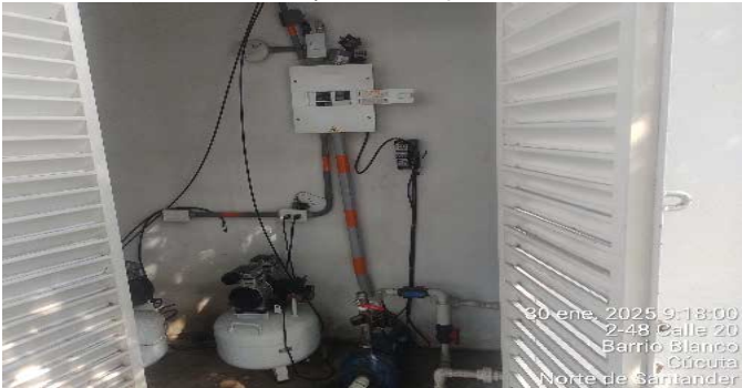
Motobomba Tanque Subterráneo Primer Piso
