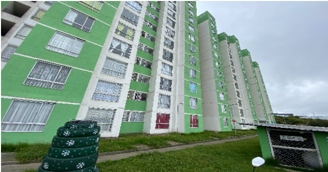
Fachada del Conjunto
