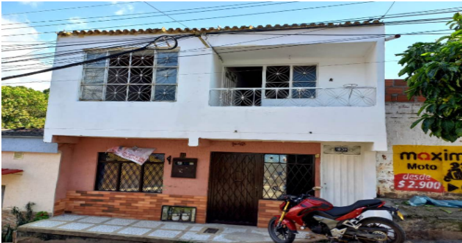
Fachada del Inmueble
