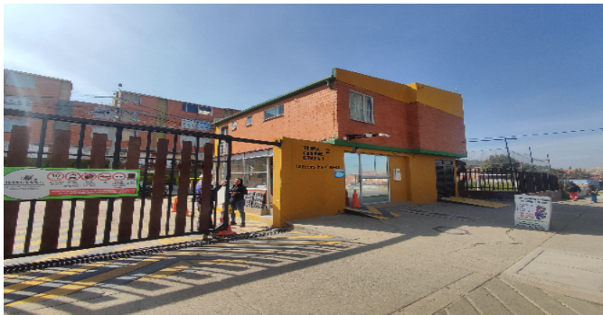
Fachada del Inmueble
