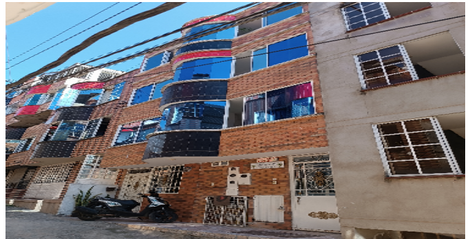
Fachada del Inmueble
