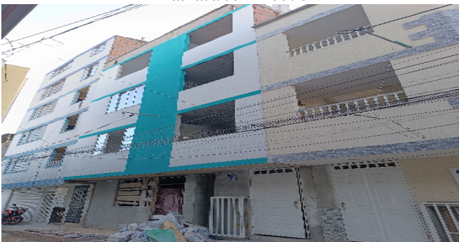
Fachada del Inmueble
