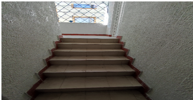
Escalera común - CJ
