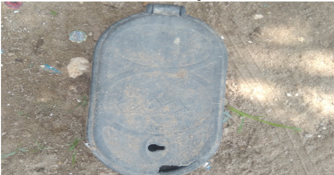
Contador de Agua
