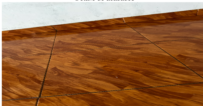
Detalle de acabados
