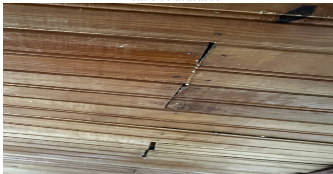
Detalle de acabados
