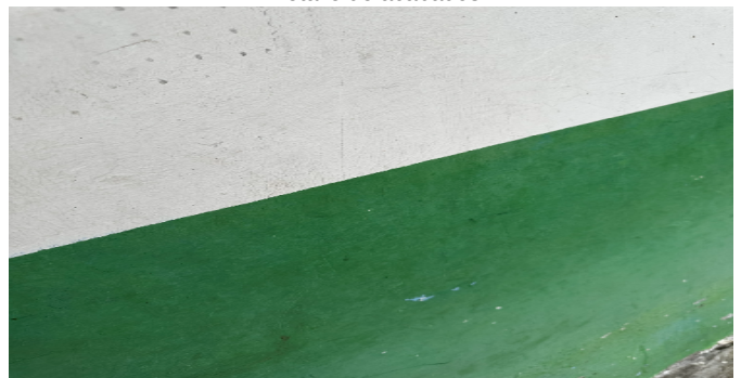
Detalle de acabados
