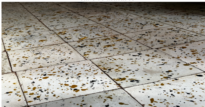
Detalle de acabados
