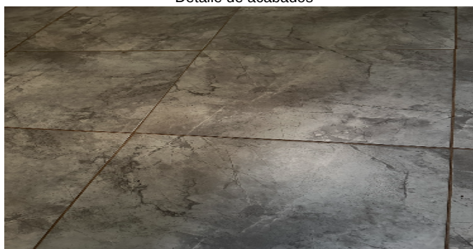
Detalle de acabados
