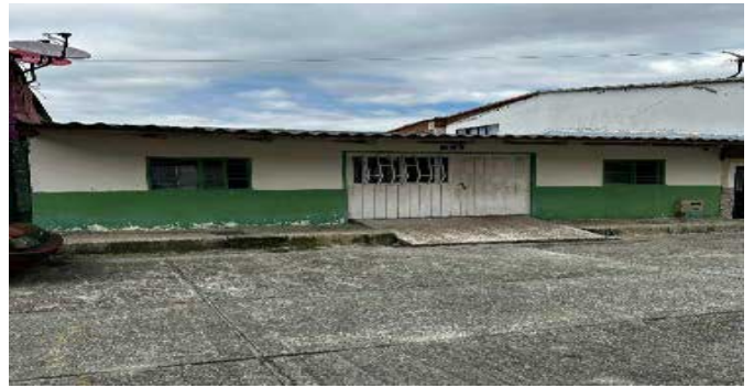
Fachada del Inmueble
