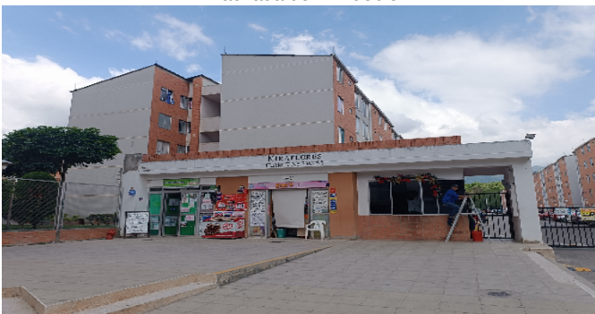
Fachada del Inmueble
