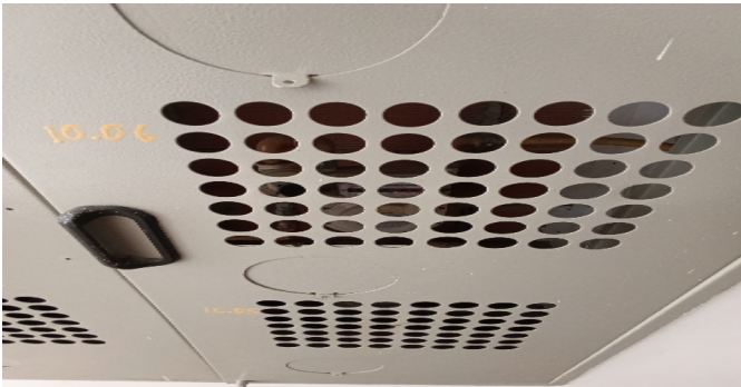
Contador de Gas
