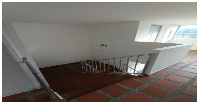
Escalera común - CJ
