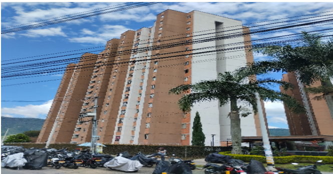
Fachada del Inmueble
