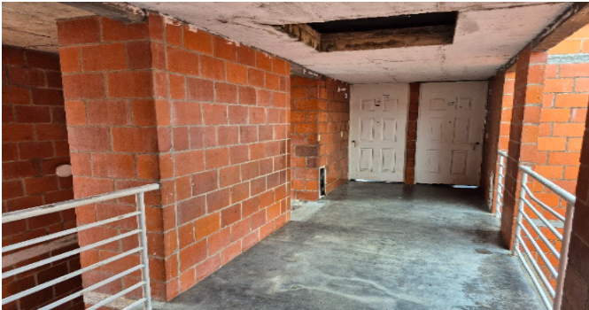
Fachada del Inmueble
