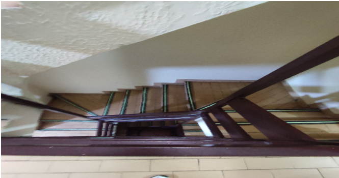
Escalera común - CJ
