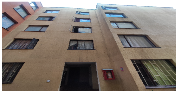
Fachada del Inmueble
