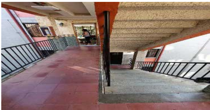
Escalera común - CJ
