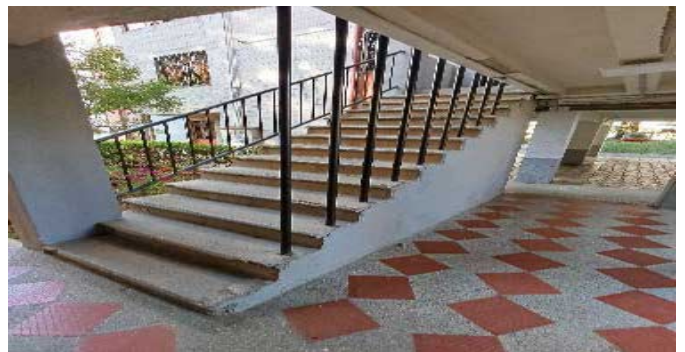
Escalera común - CJ
