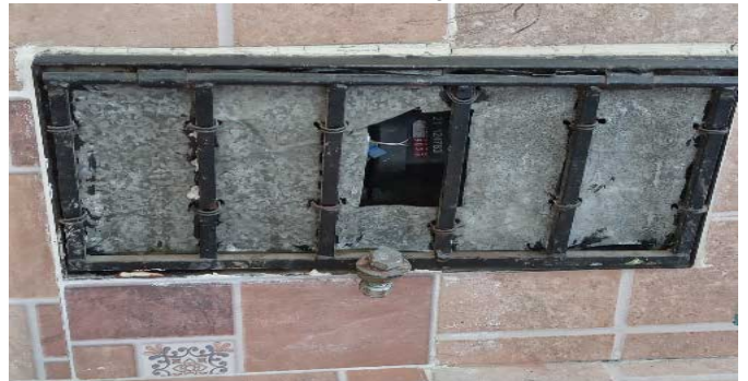
Contador de Agua
