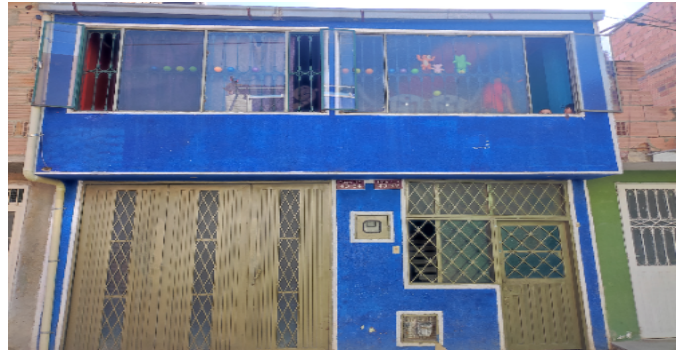
Fachada del Inmueble
