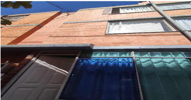
Fachada del Inmueble
