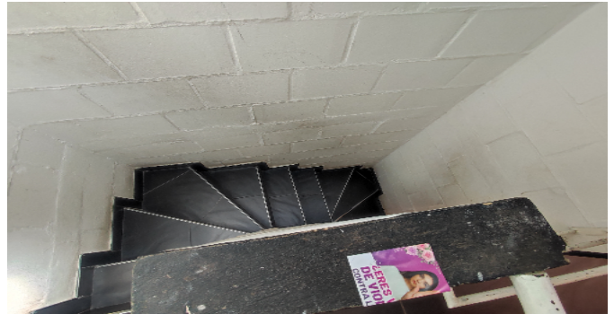
Escalera del inmueble
