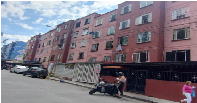
Fachada del Inmueble
