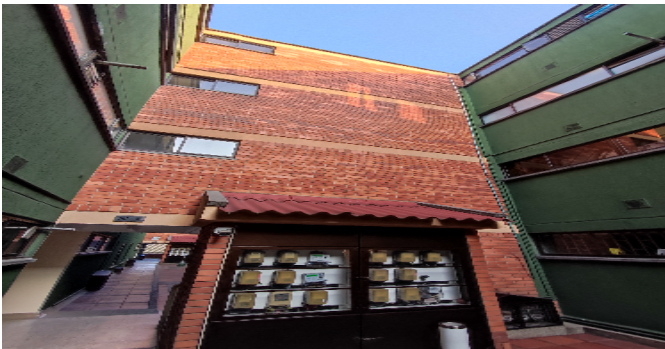
Fachada del Inmueble
