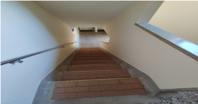
Escalera del inmueble
