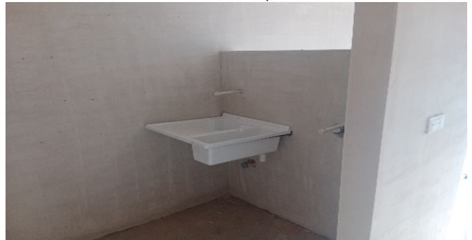
Zona de Ropas
