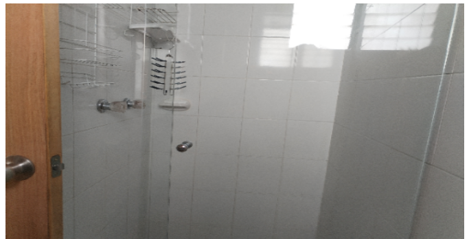
Baño Privado Hab 1
