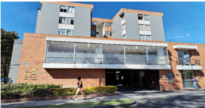
Fachada del Inmueble
