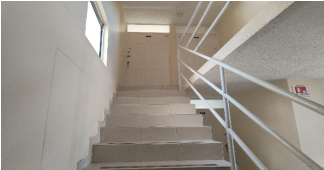
Escalera común - CJ
