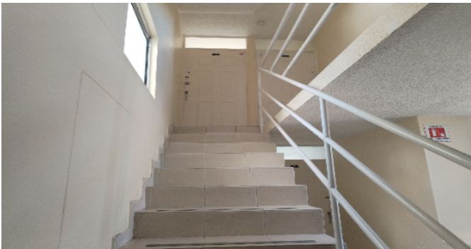
Escalera común - CJ
