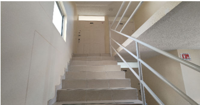
Escalera común - CJ
