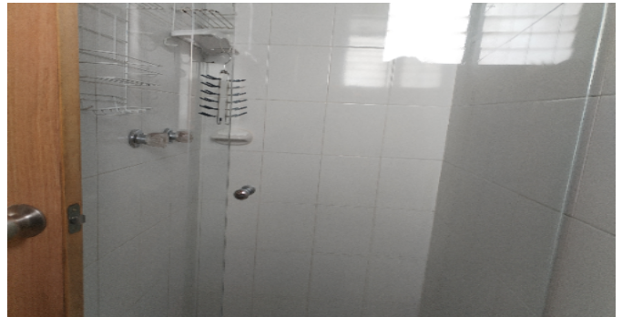
Baño Privado Hab 1
