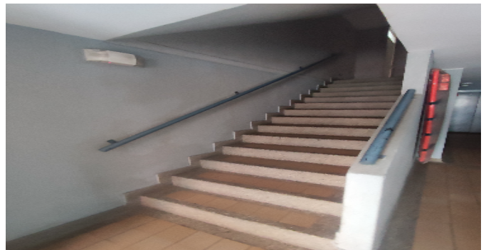
Escalera común - CJ
