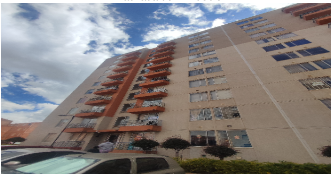
Fachada del Inmueble
