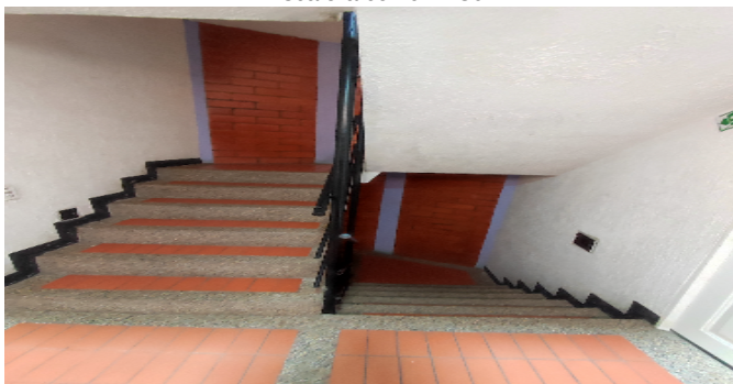
Escalera común - CJ
