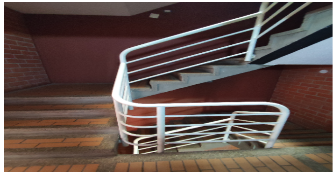
Escalera común - CJ
