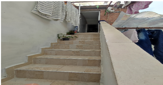
Escalera del inmueble
