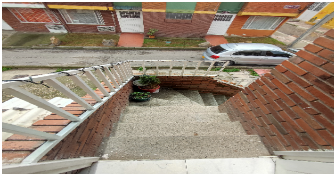
Escalera común - CJ
