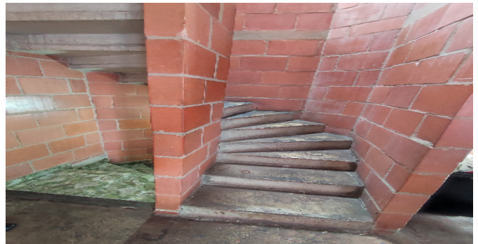
Escalera del inmueble
