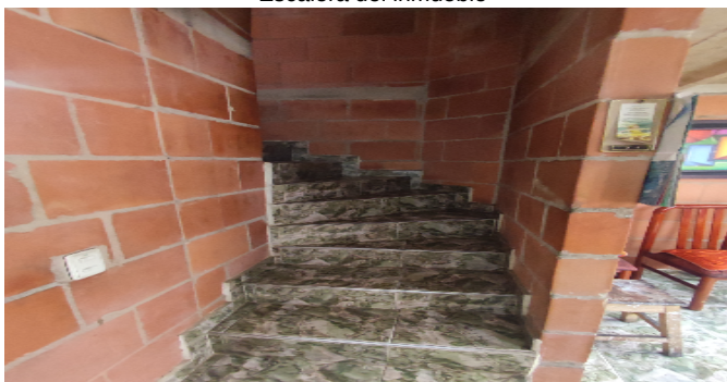
Escalera del inmueble
