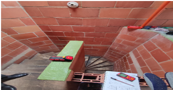
Escalera del inmueble
