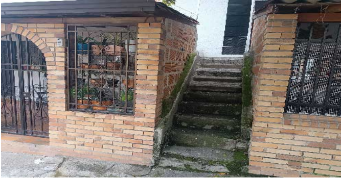
Escalera común - CJ
