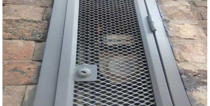
Contador de Energia
