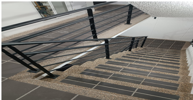
Escalera común - CJ
