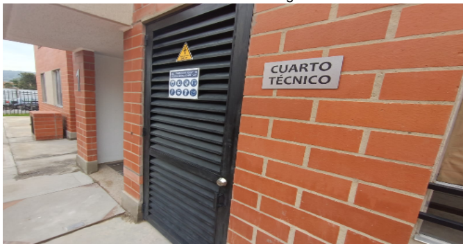
Contador de Energia
