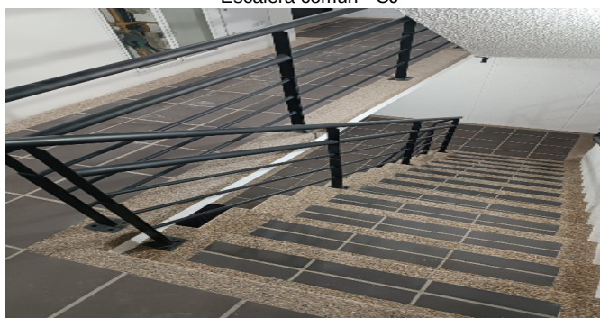
Escalera común - CJ
