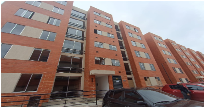
Fachada del Inmueble
