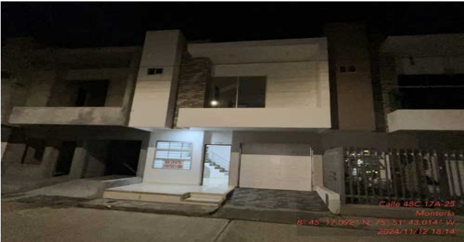
Fachada del Inmueble
