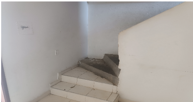
Escalera del inmueble
