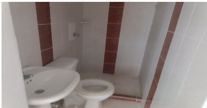
Baño Privado Hab 1
