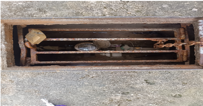
Contador de Agua
