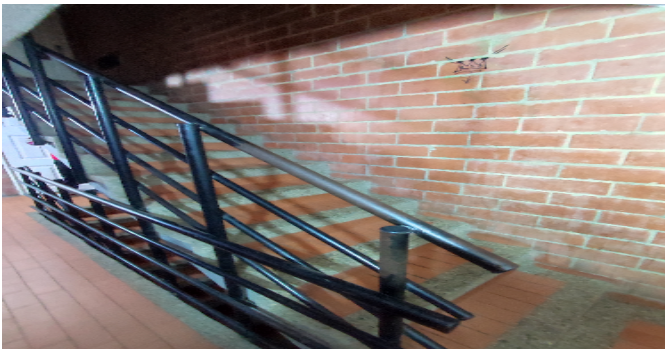
Escalera común - CJ
