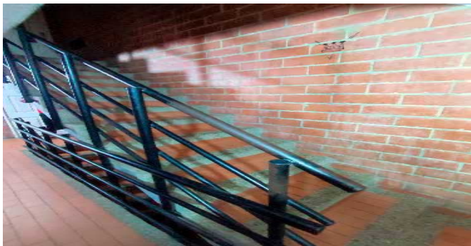
Escalera común - CJ
