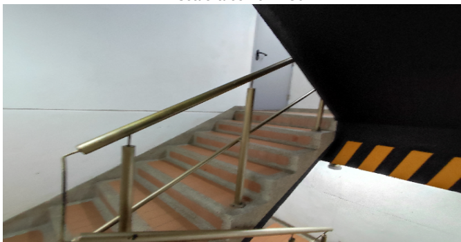
Escalera común - CJ
