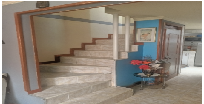
Escalera del inmueble
