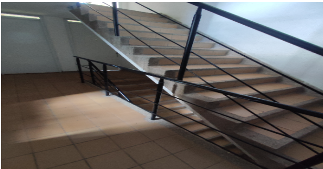
Escalera común - CJ
