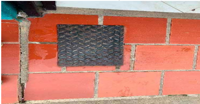
Contador de Agua
