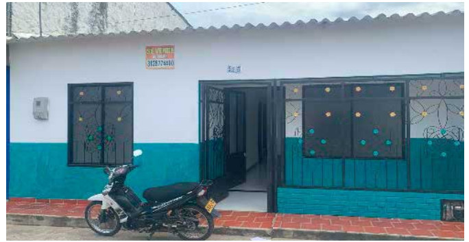
Fachada del Inmueble
