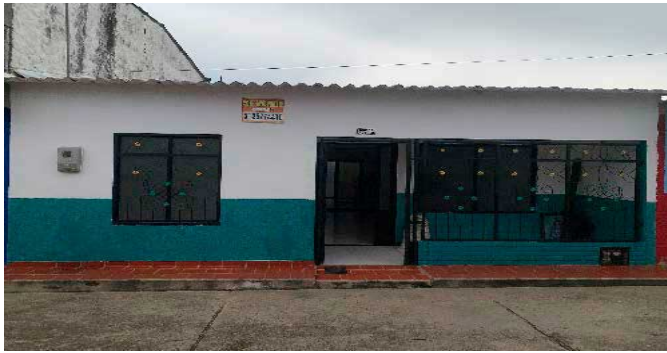
Fachada del Inmueble
